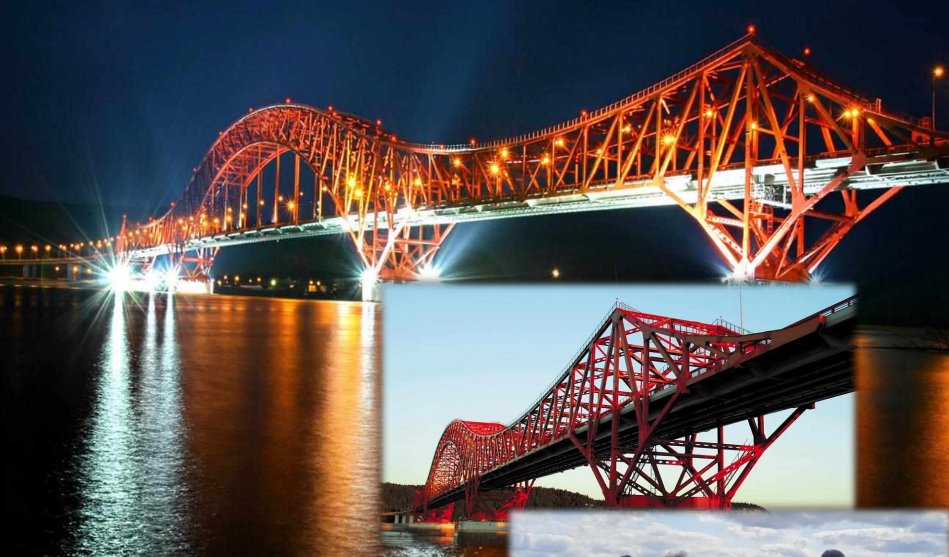
Мост «Югорский Красный дракон» Связь с Уралом 2004 г. 1320 метров, пролёт около 30 метров
