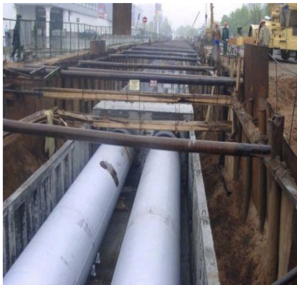
Прокладка тепловых сетей
