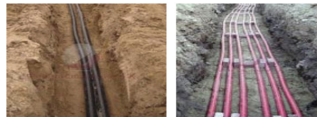
Прокладка электрических сетей
